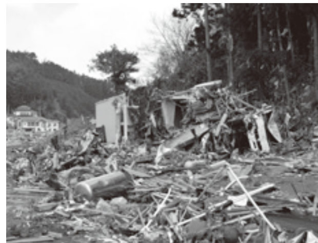
● 津波によって被害を受けた志津川伝送端局（南三陸町）
