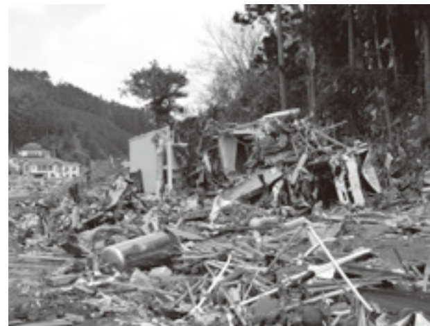
● 津波によって被害を受けた志津川伝送端局（南三陸町）
